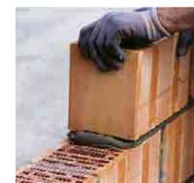
Posa del corso successivo di blocchi.
